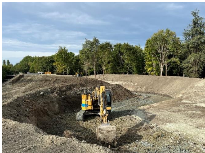
Travaux de renaturation du Bédât à Chappes – Crédits : RLV
