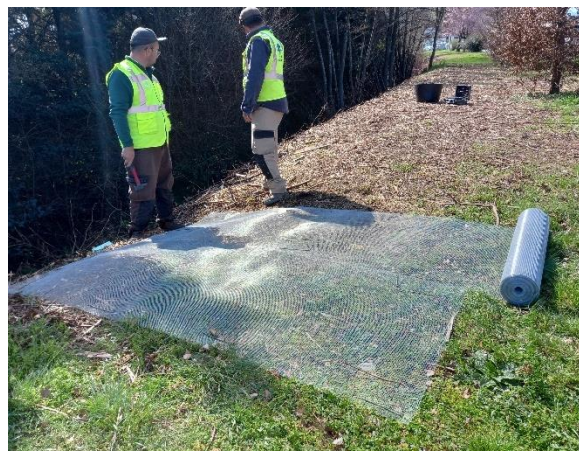
Expérimentation de pose de bâche et de grille pour la lutte contre la renouée sur le site des Charmes
