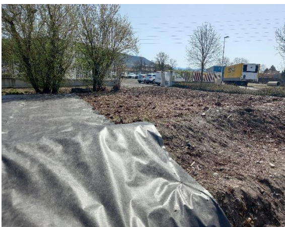
Expérimentation de pose de bâche et de grille pour la lutte contre la renouée sur le site des Charmes
